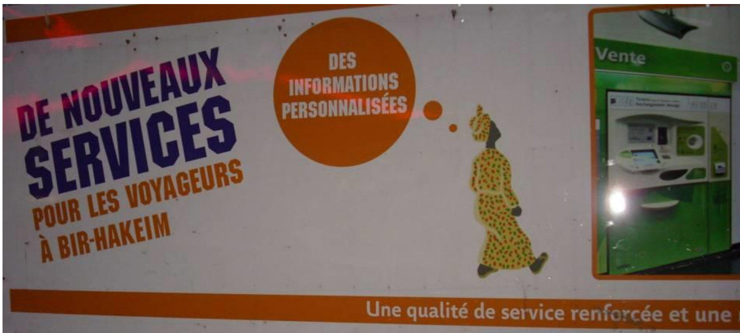
Figure 16 Travaux à la station de métro Bir-Hakeim (Paris) (Photo ST)
